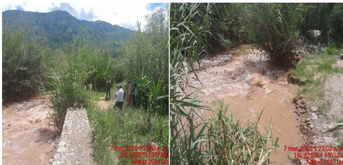
FIGURA N°03 Y N° 04 FIN DE GAVION E INICIO DE TRAMO MARGEN DERECHA CON POSIBLE INUNDACION A AREAS DE CULTIVO
