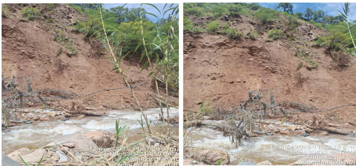
FIGURA N°09 Y 10: VISTA DE CERRO A PUNTO DE COLAPSAR POR SOCAVAMIENTO DE LA BASE PRODUCTO TRAMO II LONG 50M
