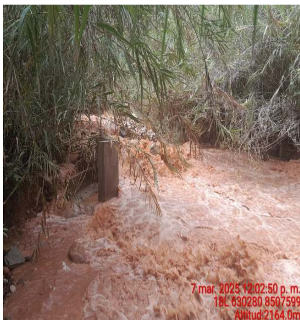
FIGURA N°11 Y N° 12 VISTA DE CAPTACION EXISTENTE Y CAUCE DE QUEBRADA QUE VIENE DESGASTANDO EL CERRO MARGEN IZQUIERDA
